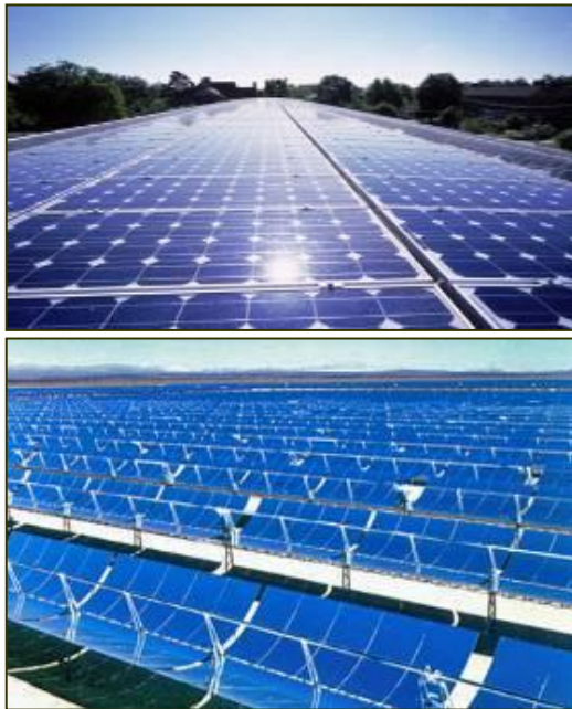
Solaire photovoltaïque/ thermique
