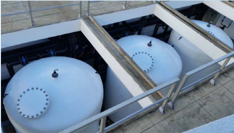
Figura 1. Lechos de calcita soterrados para evitar el impacto visual.
